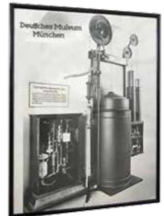
Erster selbsttätiger Rauchgasprüfer "ADOS" aus dem Jahre 1900. Durch den Kaminzug angetrieben, nimmt das Gerät 10 mal pro Stunde eine Probe des Rauchgases, analysiert es automatisch und zeichnet seinen Kohlensäuregehalt auf. Dieser bildet den Maßstab für die wirtschaftlichste Brennstoff-Ausnutzung durch das Heizer-Personal. Sie liegt bei 15% Kohlensäure-Gehalt in den Feurgasen.
